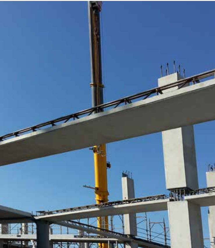
Trave PREM a2 su Pilastrì PaNUS br e pareti a doppia lastra a2 PREM beams on br PaNUS columns and sandwich walls
