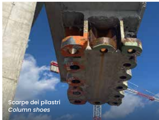
Nodo di giunzione dei pilastrì MaNUS bc sotto quota solaio bc MaNUS column joint placed below slab level
