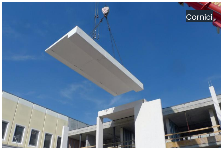
Pannelli di tamponamento esterni a taglio termico
