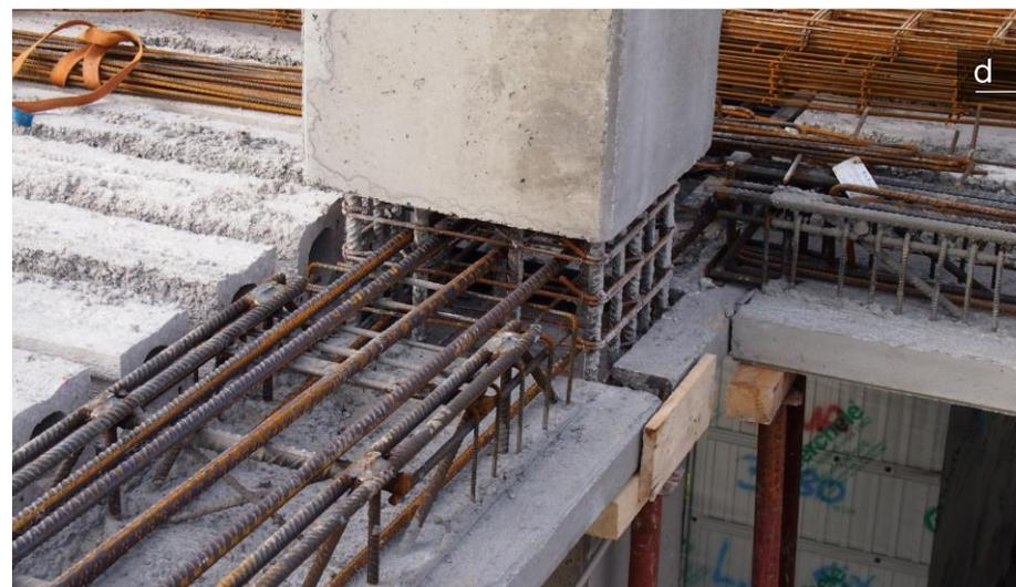
Dettagli costruttivi al terzo solaio: a) nodo con travi a 45°; b) monconi superiori in attesa di essere traslati nel nodo; c) nodi con monconi posati; d) nodi con monconi posati nelle due direzioni e staffe di confinamento.
