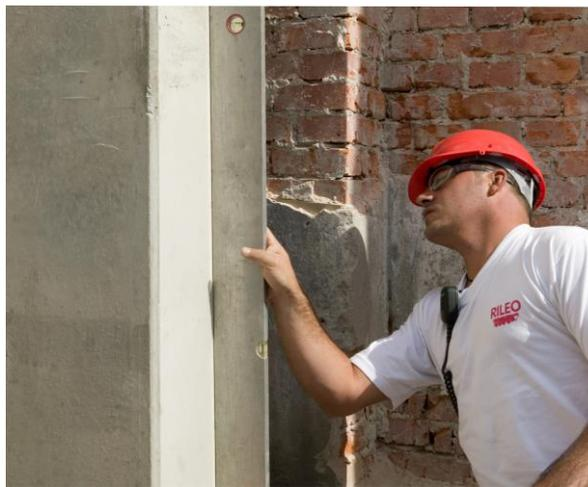
Segue il posizionamento ed il fissaggio dei pilastri sui tirafondi e l'inghisaggio, con malta antiritiro, attraverso le guaine fuoriuscenti da una faccia laterale. Le scarpe dei pilastri, marcate CE, garantiscono un veloce posizionamento ed una efficace continuità strutturale...
