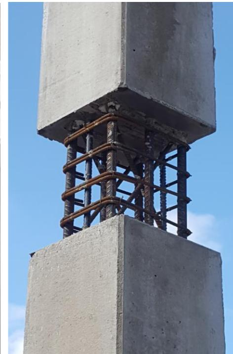
Il nodo umido comporta il passaggio integrale della gabbia del pilastro, attraverso il nodo, appositamente arretrata dal bordo per permettere la posa delle travi.
