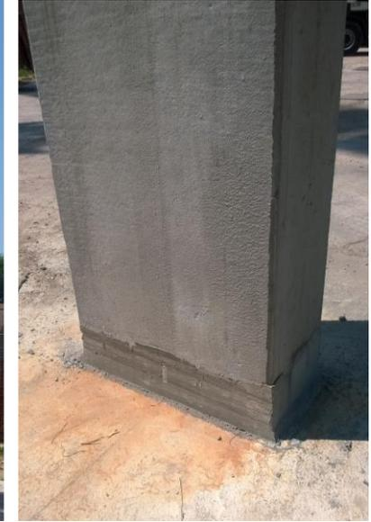
Gli elementi verticali delle scarpe dopo il serraggio dei bulloni, vengono inghisati con malta espansiva, attraverso le guaine fuoriuscenti da una faccia laterale, pronti per la posa in autoportanza di travi, solai e scale.
