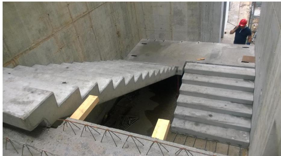
...muri prefabbricati delle scale, rampe prefabbricate, e relativi pianerottoli, velette e cornici a completamento del sistema costruttivo...
