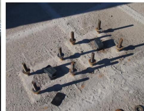
Le dime risulteranno complanari all'estradosso del getto a meno delle tolleranze dichiarate. L'inserimento in fondazione dei tirafondi attraverso il posizionamento planialtimetrico delle dime è una fase molto delicata da cui dipende la riuscita di tutte le fasi successive del montaggio dei prefabbricati.
