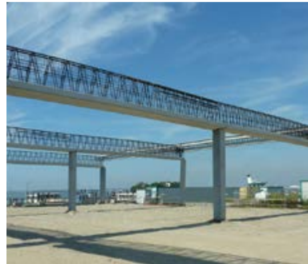
Travi PREM a2 Pilastrini PANUS br PREM a2 Beams PANUS br Columns
