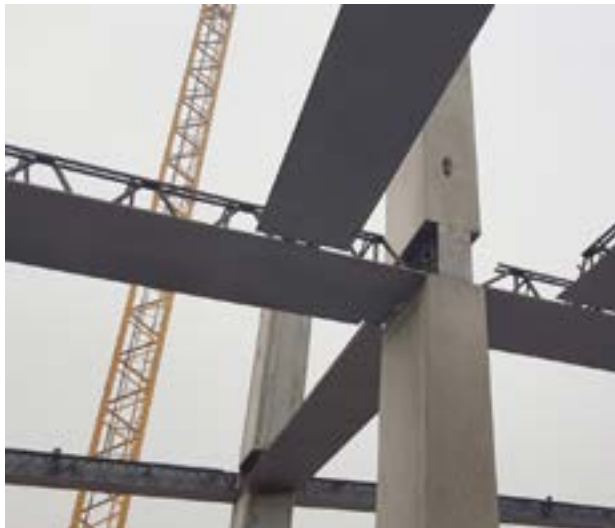
Travi PREM a1 Pilastrini PANUS br PREM a1 Beams PANUS br Columns
